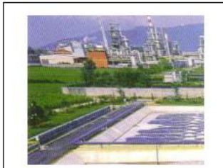
Depurazione Acqua & Aria - Civili industriali ... Speciali
