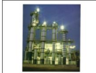
E & F Plant - Energia Pulita e Furfurolo
